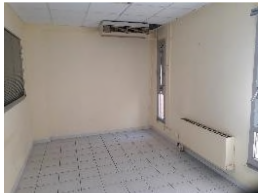
Photographie 2 : Ancien bureau / chauffage gaz
