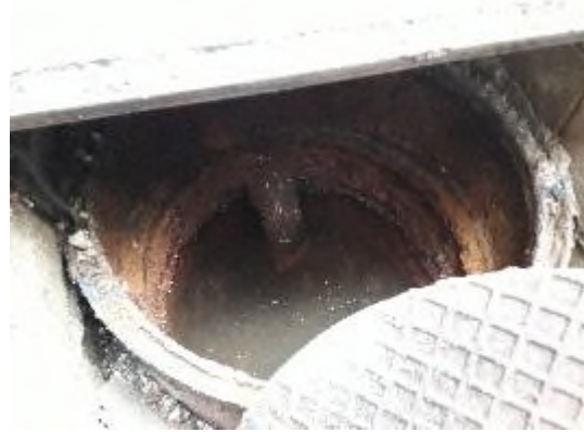
Photographie 6 : Point bas d'eau dans le regard devant la chaufferie
