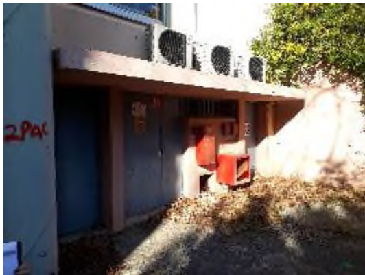
Photographie 7 : Local chaufferie (non visité) et groupes de climatisation
