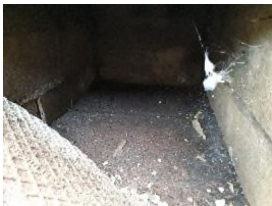
Photographie 9 : Vide sanitaire du bâtiment
