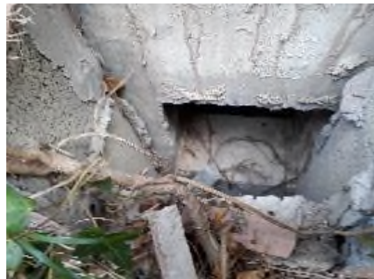
Photographie 8 : Aération du vide sanitaire
