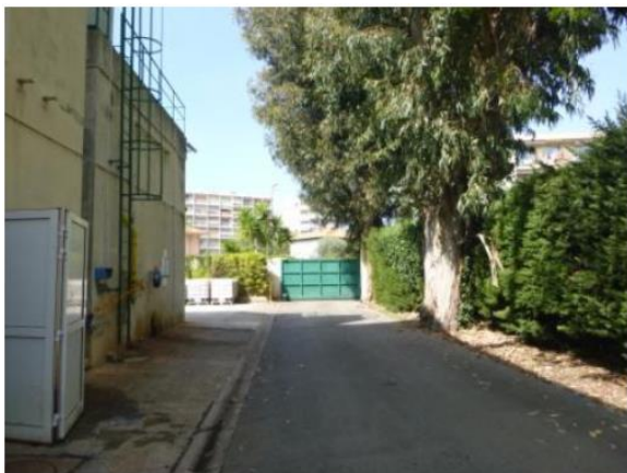
Bâtiment et espaces verts de la STEP
