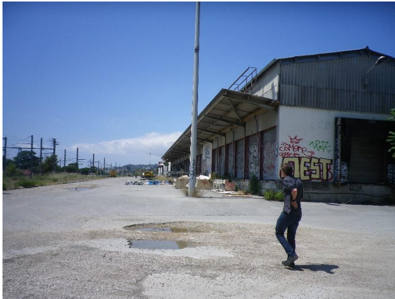
Photo 1 : Site d'implantation de la nouvelle STEP
