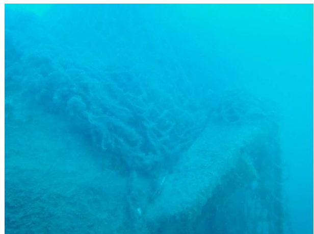
Figure 5 : Partie non ensouillée de l'émissaire au niveau du coude autour de 15 m de profondeur
