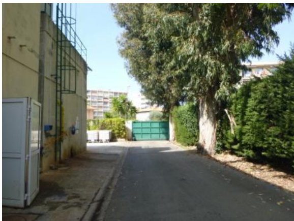
Bâtiment et espaces verts de la STEP
