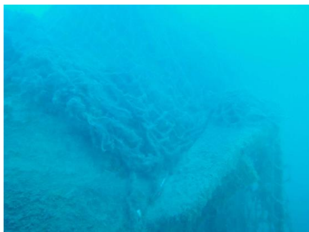
Figure 2 : Partie non ensouillée de l'émissaire au niveau du coude autour de 15 m de profondeur
