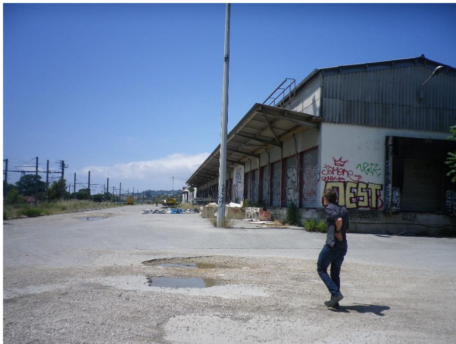
Photo 2 : Site d'implantation de la nouvelle STEP
