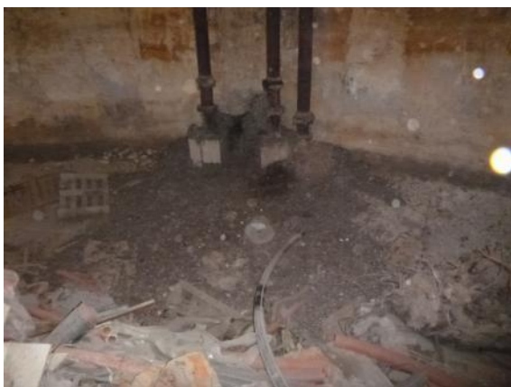
Guano de Pigeon biset accumulé depuis des années dans l'ancien décanteur
