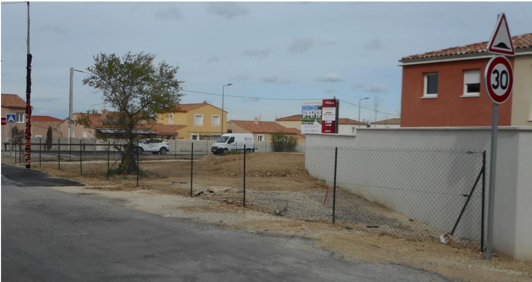
5/ Vue sur l'emplacement prévu pour le futur bassin de rétention (mars 2017)
