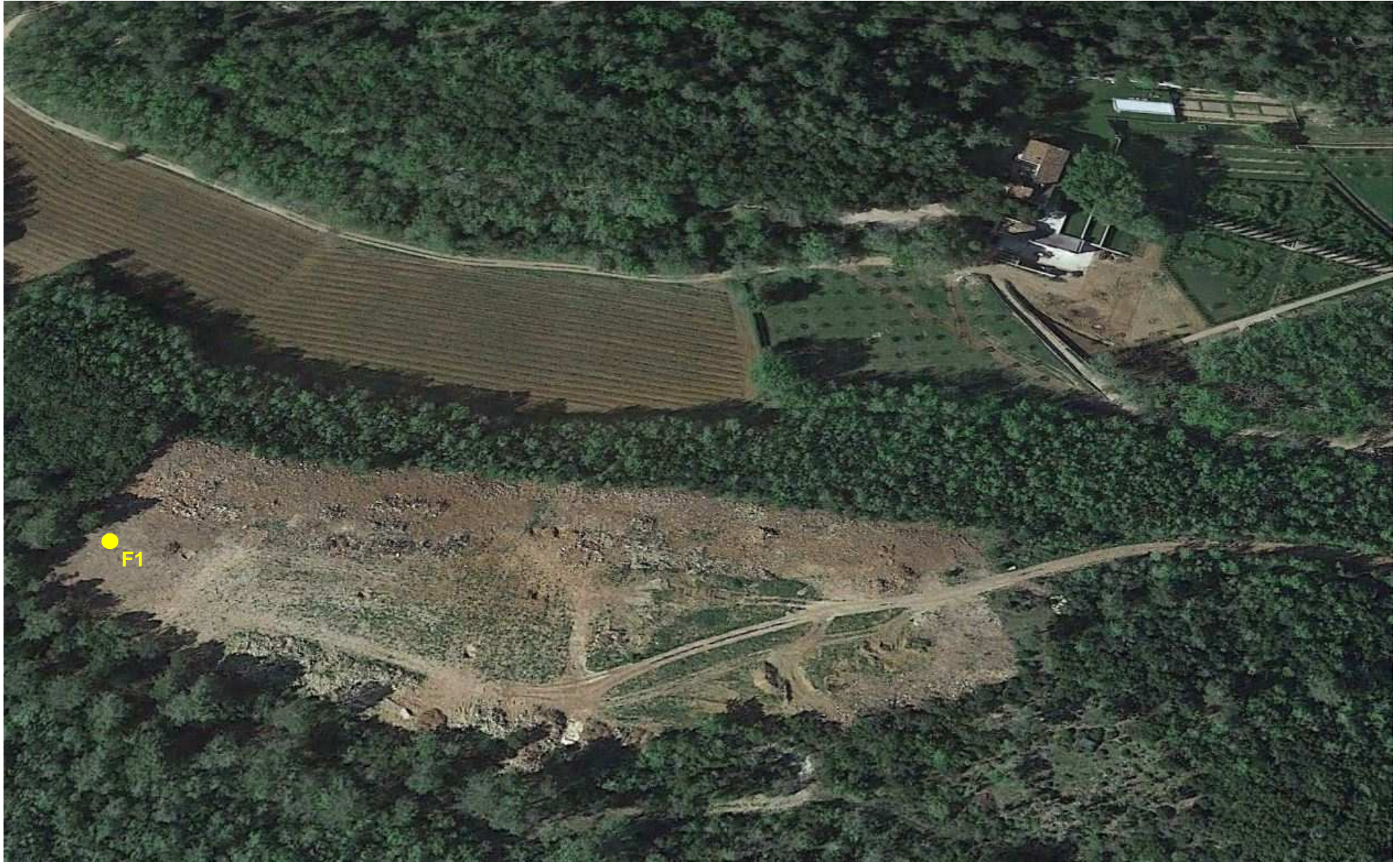
Emplacement du forage F1
