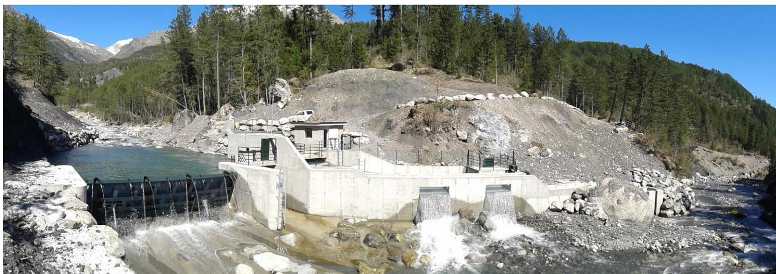
Exemple d'une prise d'eau équipée d'un barrage mobile
