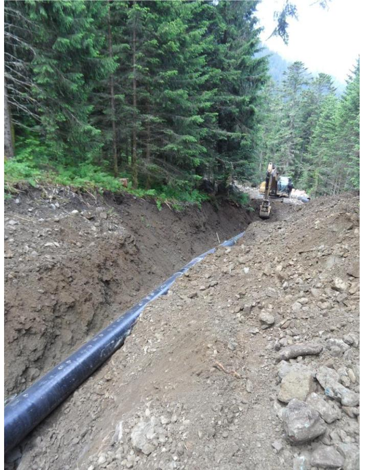
Exemple de pose de conduite forcée en acier de diamètre 600 mm
