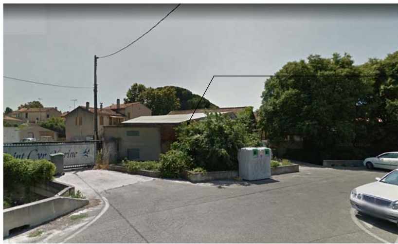
Hangar existant à démolir
