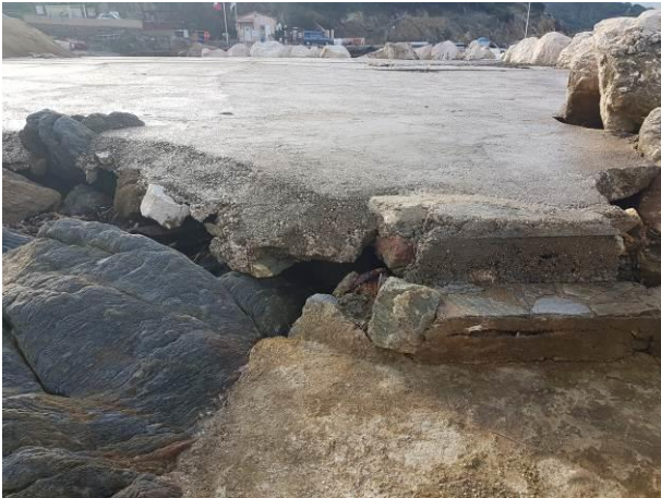
Figure 40 : Affouillements
