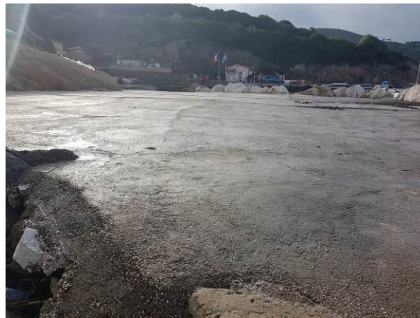
Figure 42 : Affouillement et multiples fissures et fractures
