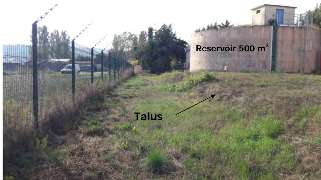
Figure 7 - Talus et remblai dans le PPI
