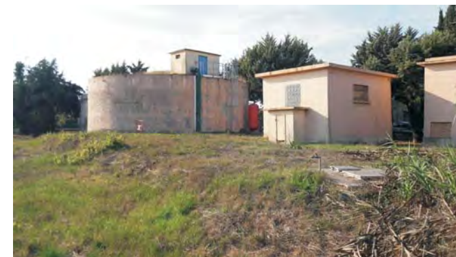
C. Vue sur le réservoir 500 m3
