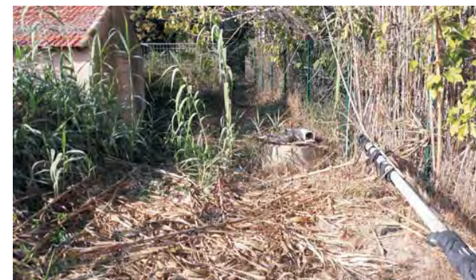
F. Fossé récupération des eaux de surverse
