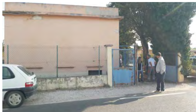
B. L'entrée du site et le bâtiment des pompes et du forage P4
