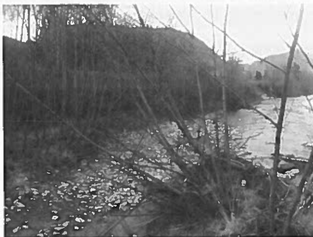
Aspect de la digue du Buëch au point du débouché du projet
