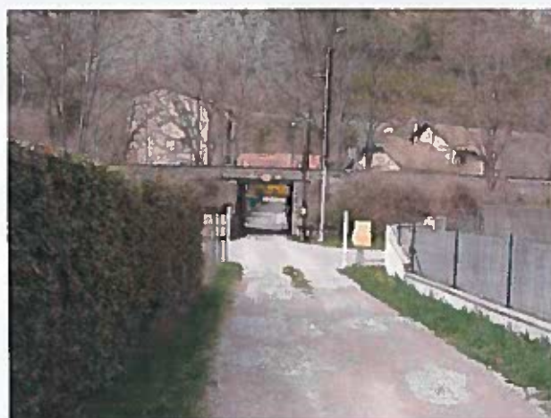
Chemin Dominique Chaix (passage sous la voie SNCF)
