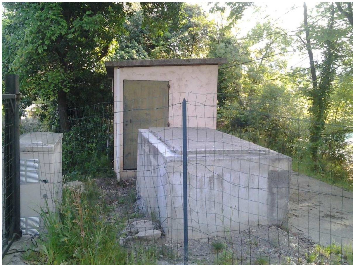
Photo 1 (BG.Consultant) : vue du forage d'exploitation au sein de son périmètre de protection.
