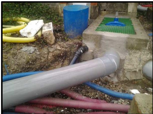
**Photo 5 (BG.Consultant 2014) :** sortie du captage bas (PVC à gauche : sortie actuelle, PVC central : sortie vers bache de mélange, PE noir : trop plein)
