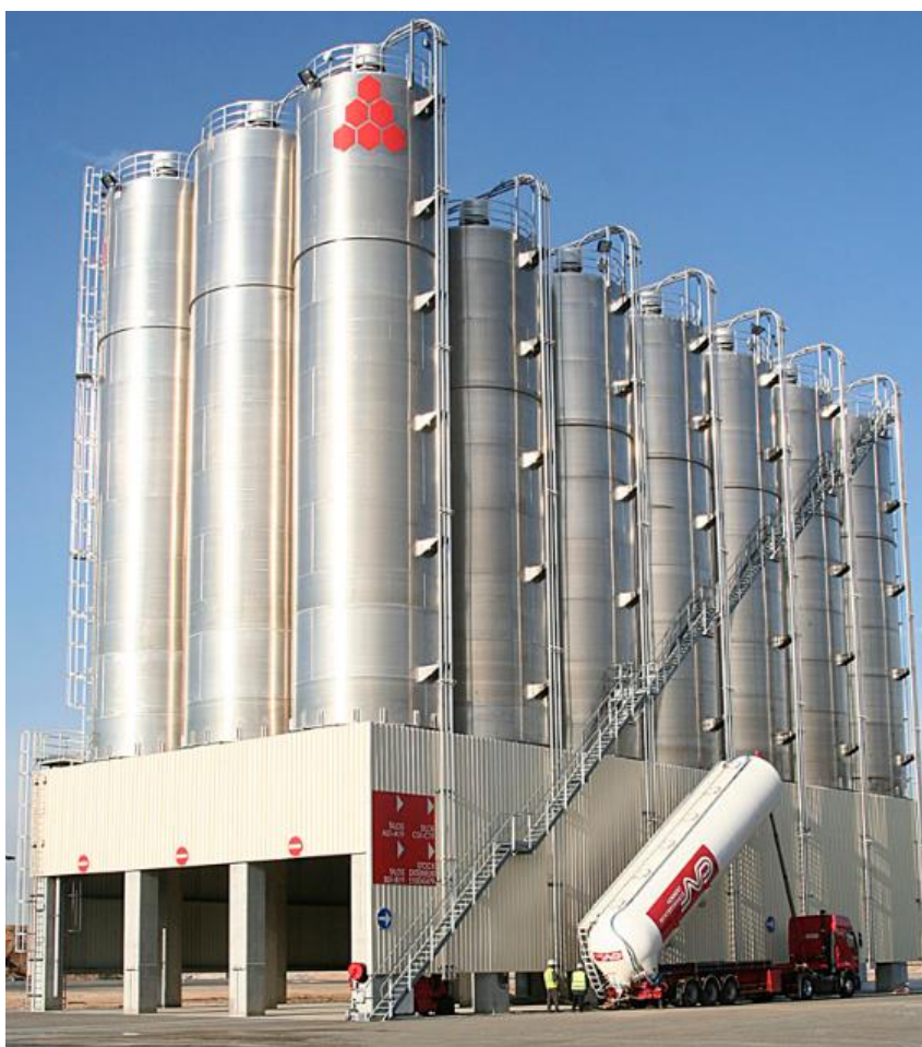
Photo 4: Déchargement d'un camion-citerne dans un silo
