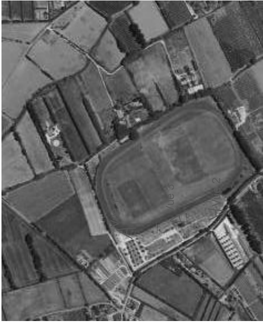
Photos du 02 Septembre 2016
