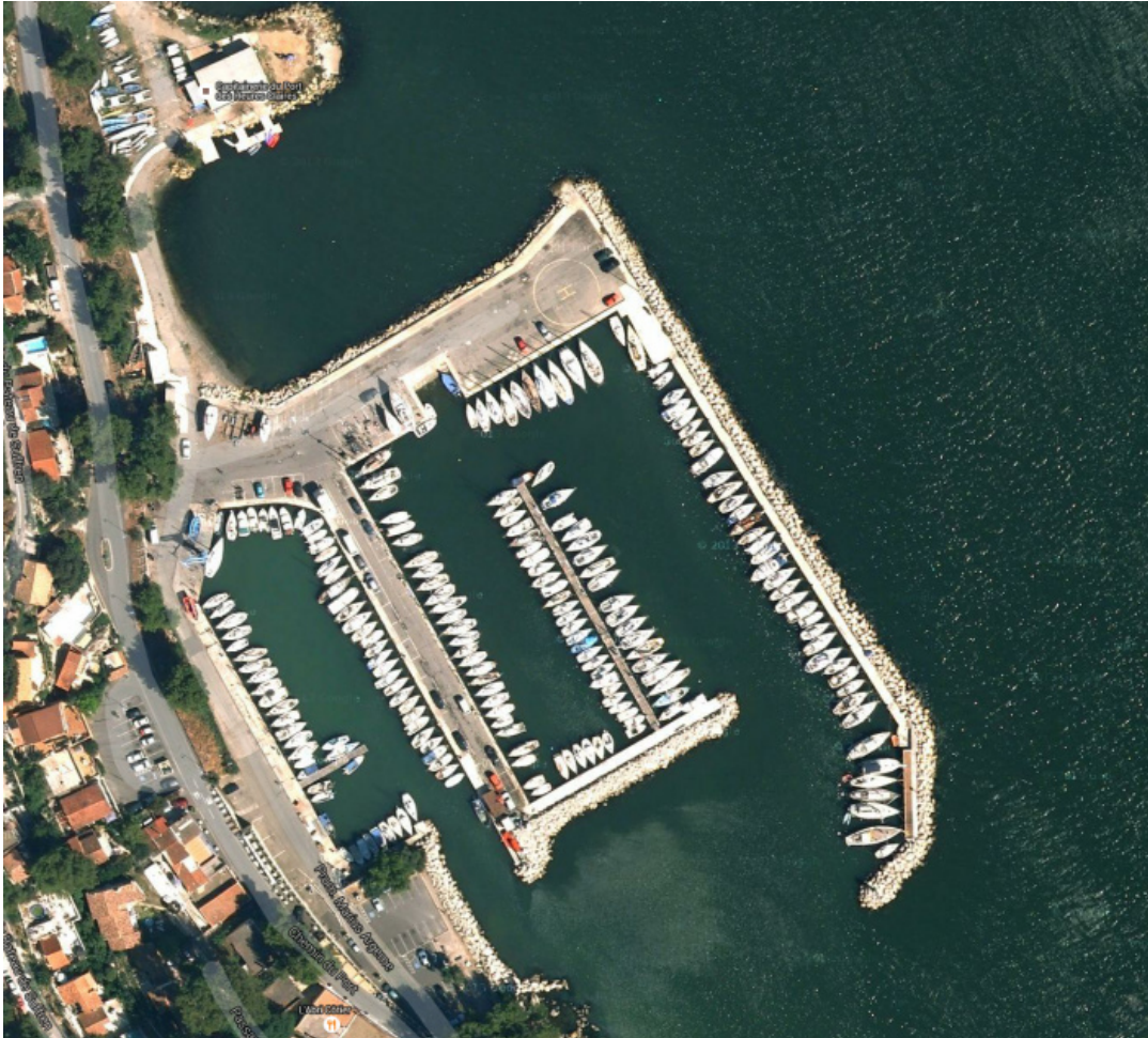
Figure 1 : port des Heures-claires à Istres (Google earth).
