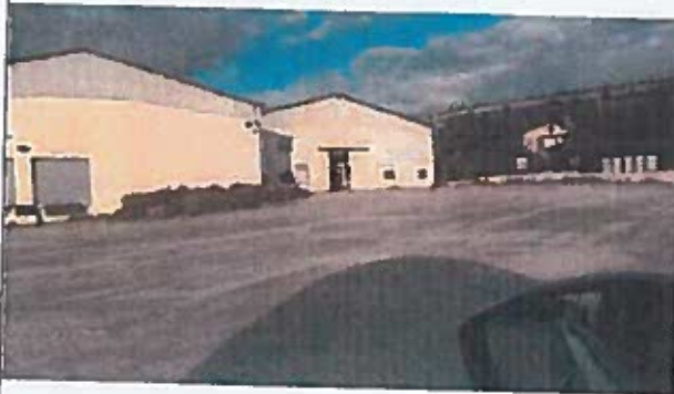
Vue sud du bâtiment 1 : Vivendia
