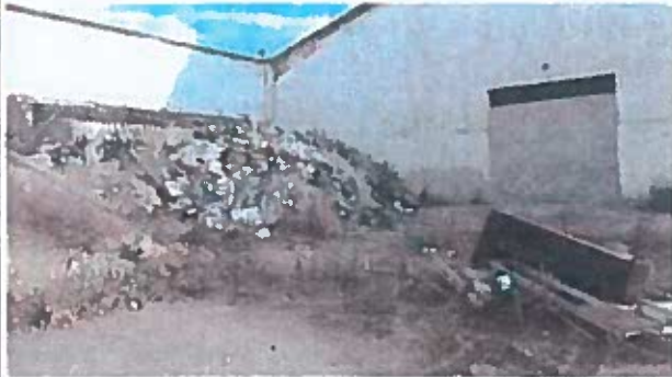
Nord du bâtiment 2 : déchets divers
