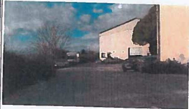
Vue sud du bâtiment 1 : pro bureau d'aménagement toujours à la location
