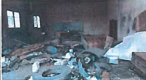
Nord du bâtiment 2 : atelier mécanique accessible
