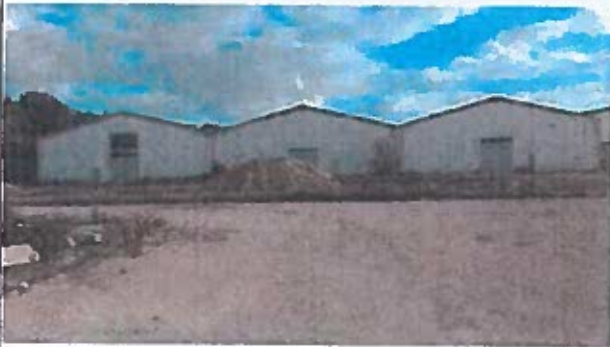
Façade nord du bâtiment 3 : tas de terres, les entrées sont murées
