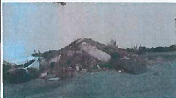
Nord du bâtiment 4 : terres et bétons
