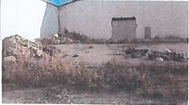
ouest du bâtiment 4 : tas de terres et déchets
