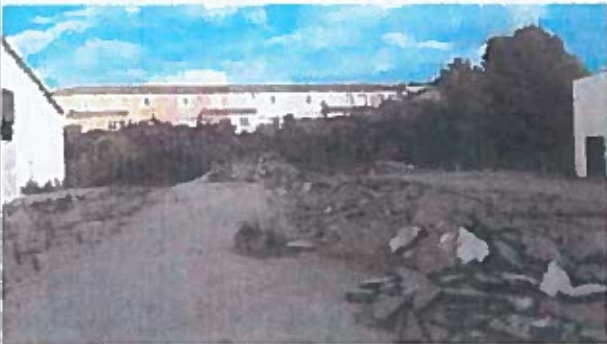
Nord du bâtiment 2 : enrobés
