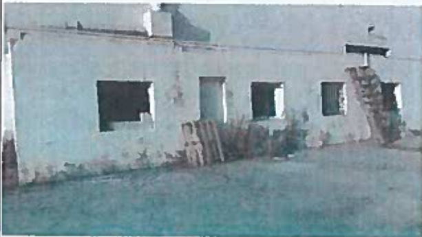
Bureau du bâtiment 3 accessible
