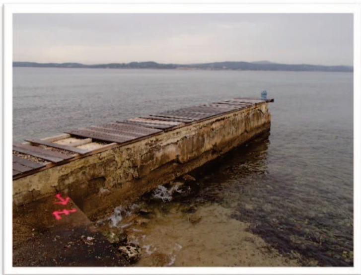
- Photo n°4 _ Ponton à réhabilité -
