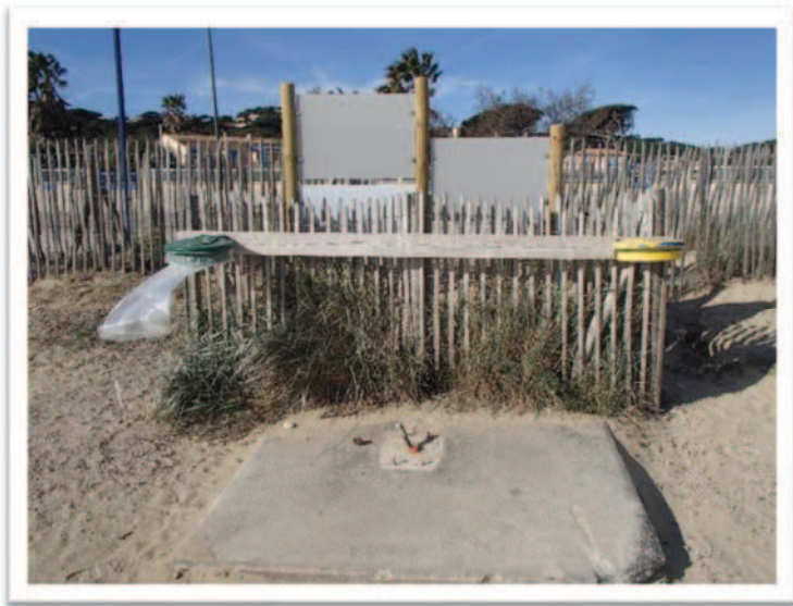
- Photo n°5 _ Mise en place de douches PMR -
