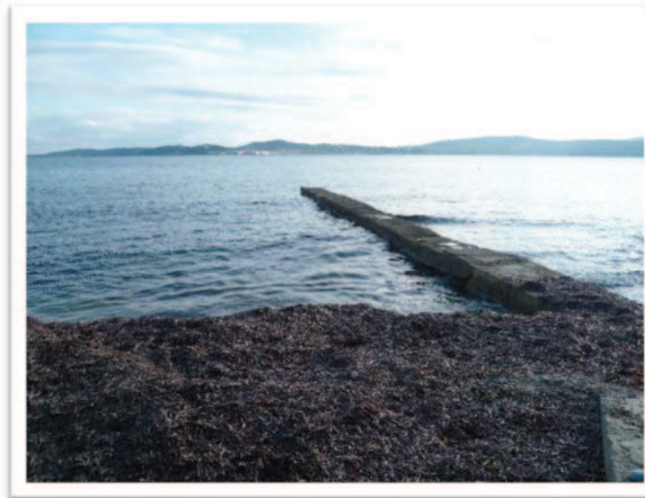
- Photo n°2 _ Ponton existant -
