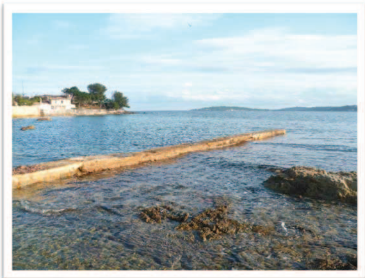
- Photo n°3 _ Ponton existant -
