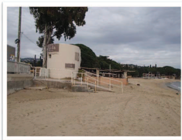
- Photo n°3 _ Accès plage à réaménager pour accéder au puits collecteur, site pour implantation du ponton léger, poste de secours et accès PMR -
