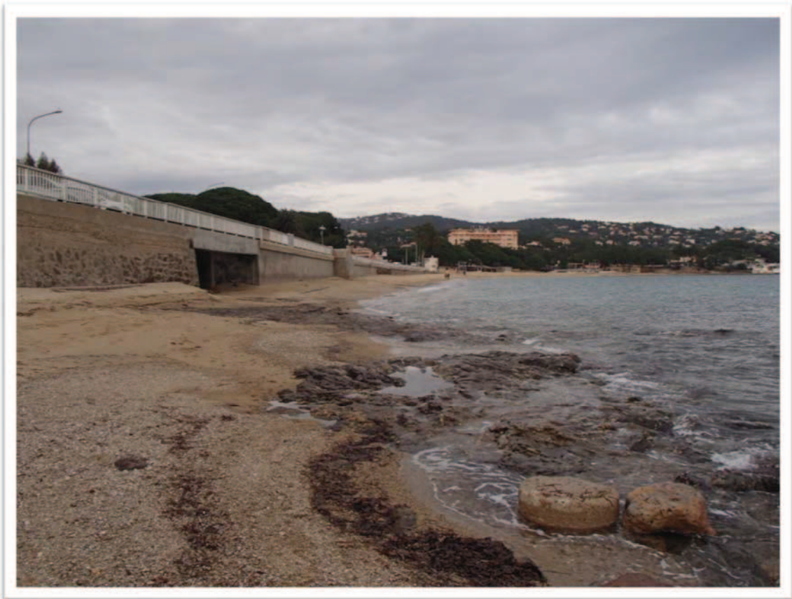
- Photo n°4 _ Plage Coté l'Ouest -
