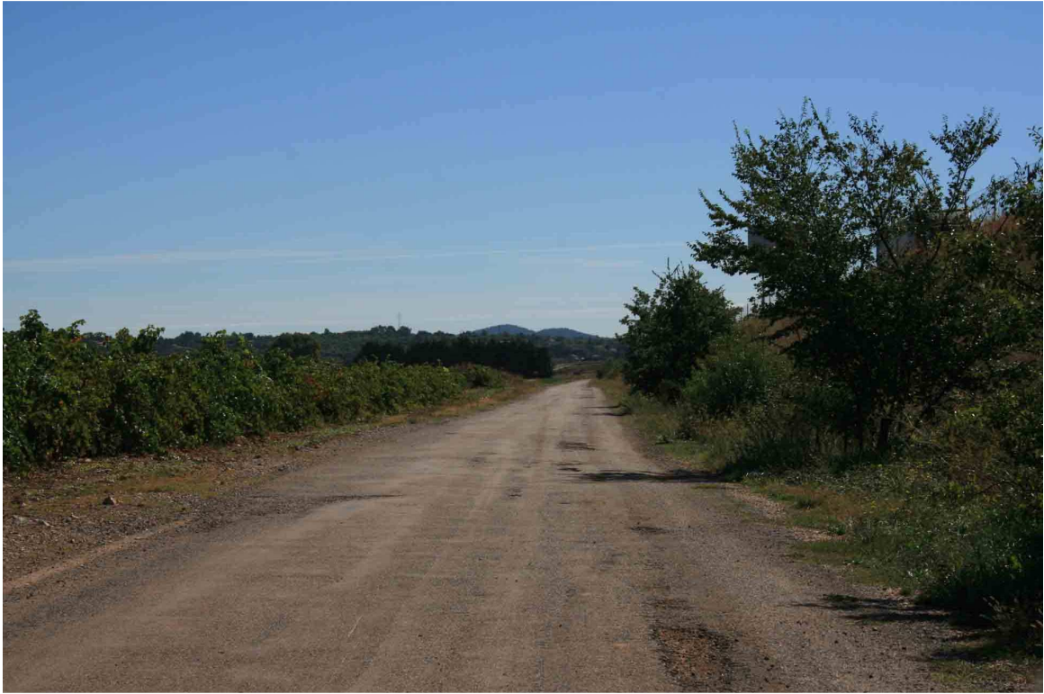
Photo 5 : Route longeant l'autoroute A8 et suivi par la liaison souterraine.
