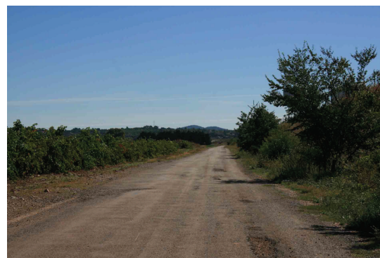
Voie de circulation longeant l'autoroute A8 sur son côté nord.
