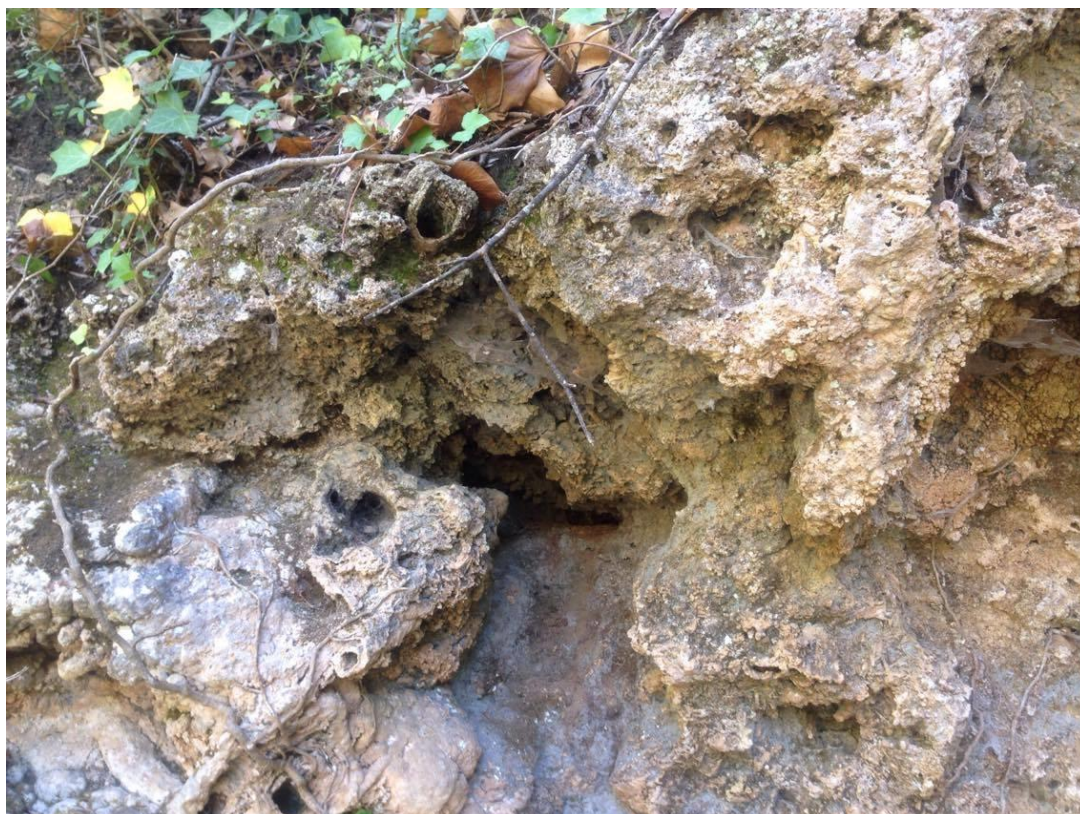
Figure 11: Photo des tufs présents au site d'Entraigues (ICEA, 02/09/2016)
