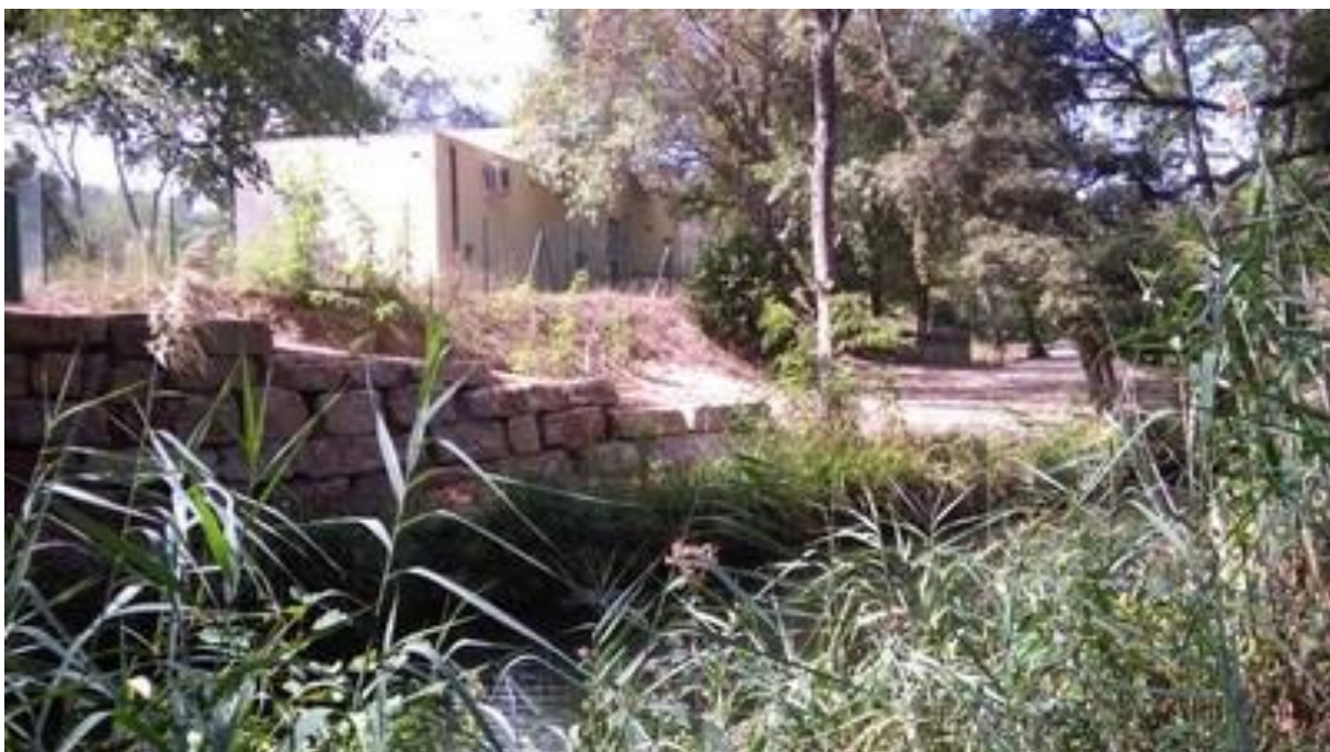
Figure 77 : vue du bras mort de l'Argens en bordure Est des installations de captage (ICEA, 02/09/2016)
