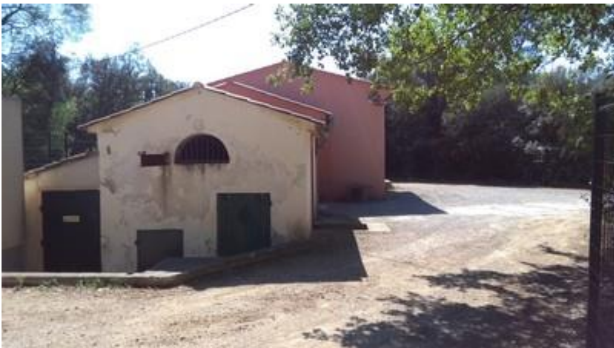
Figure 7 : infrastructures de la commune de Vidauban (ICEA 02/09/2016)
