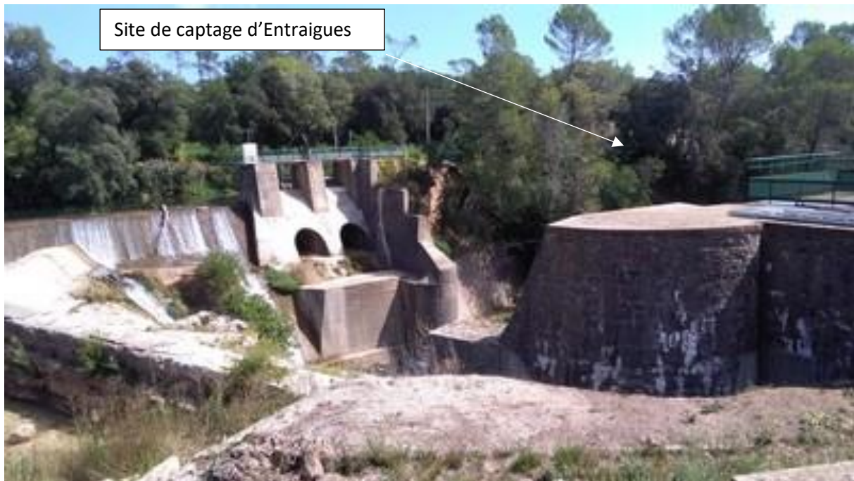
Figure 75 : vue amont du barrage hydroélectrique (ICEA, 02/09/2016)
