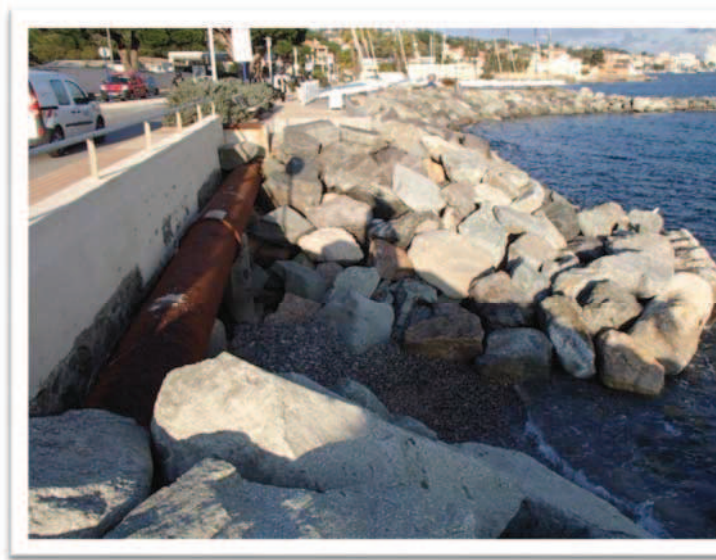
- Photo n°5 _ Perré à proximité l'école de voile -
