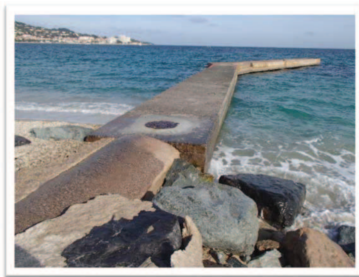
- Photo n°6 _ Ponton béton armé -
