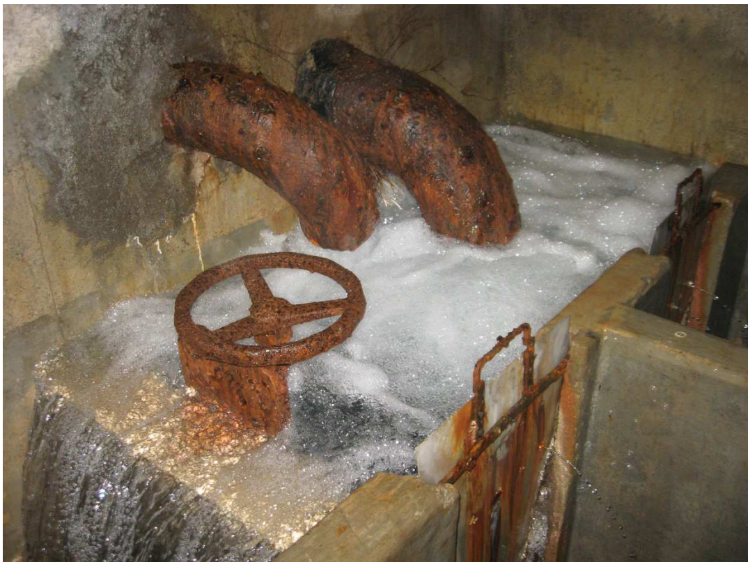
Photo intérieure de l'ouvrage de réunion
