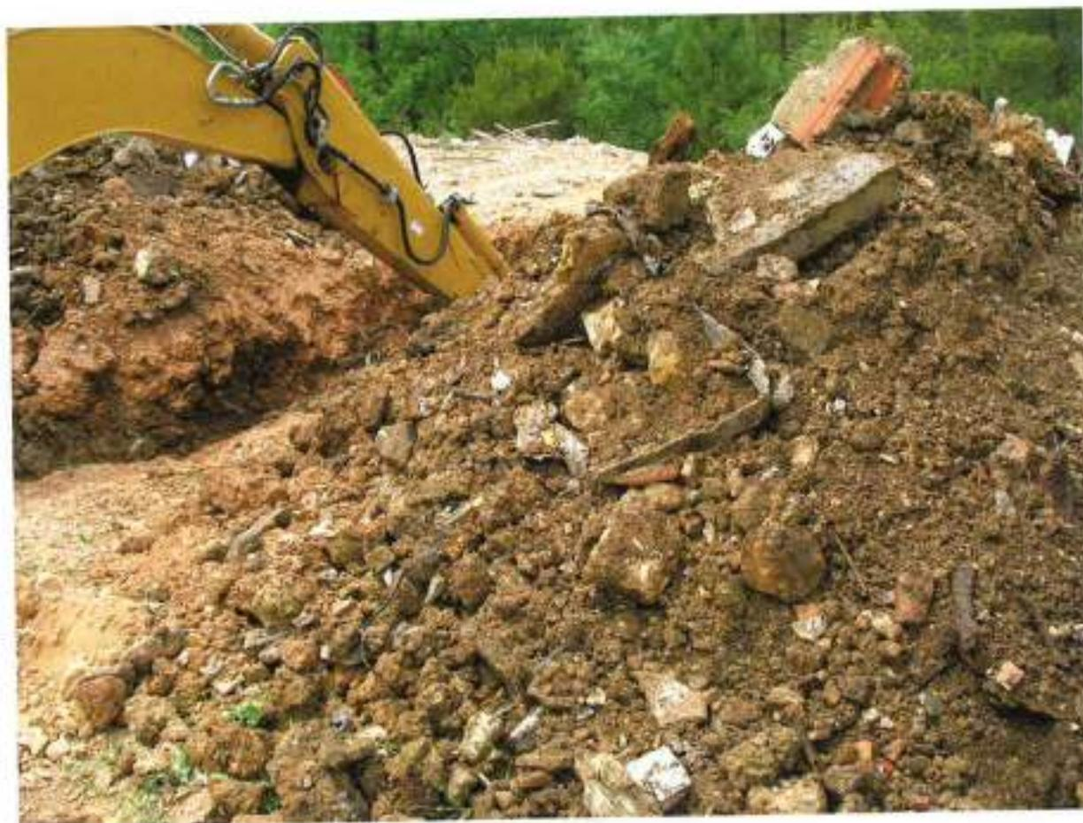
**Photo 1** : Sondage sur la plate-forme supérieur : accumulation majoritaire de matériaux inertes
