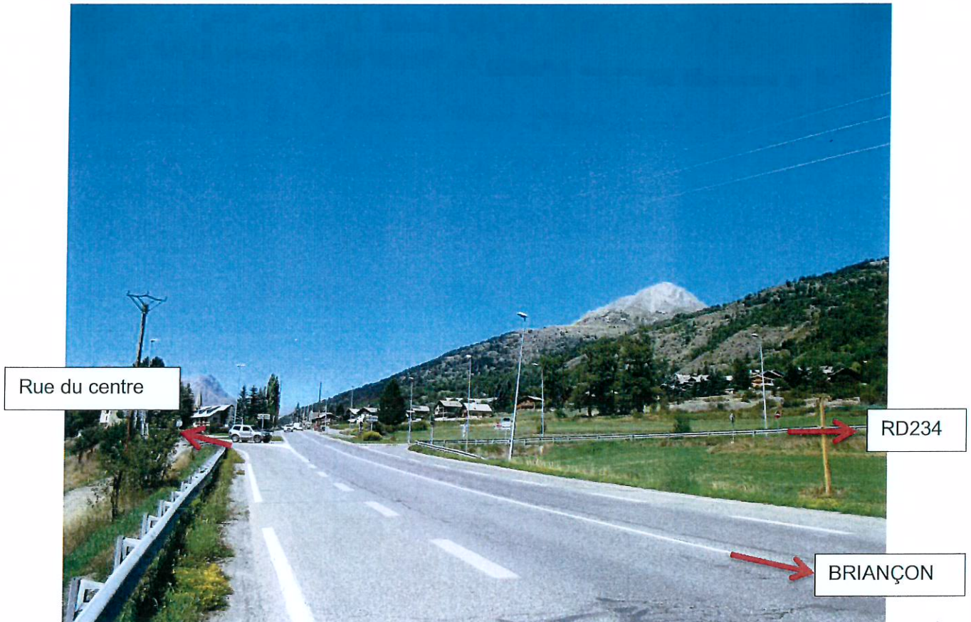
PHOTO 1- Prise de vue dans le sens BRIANÇON->GRENOBLE
