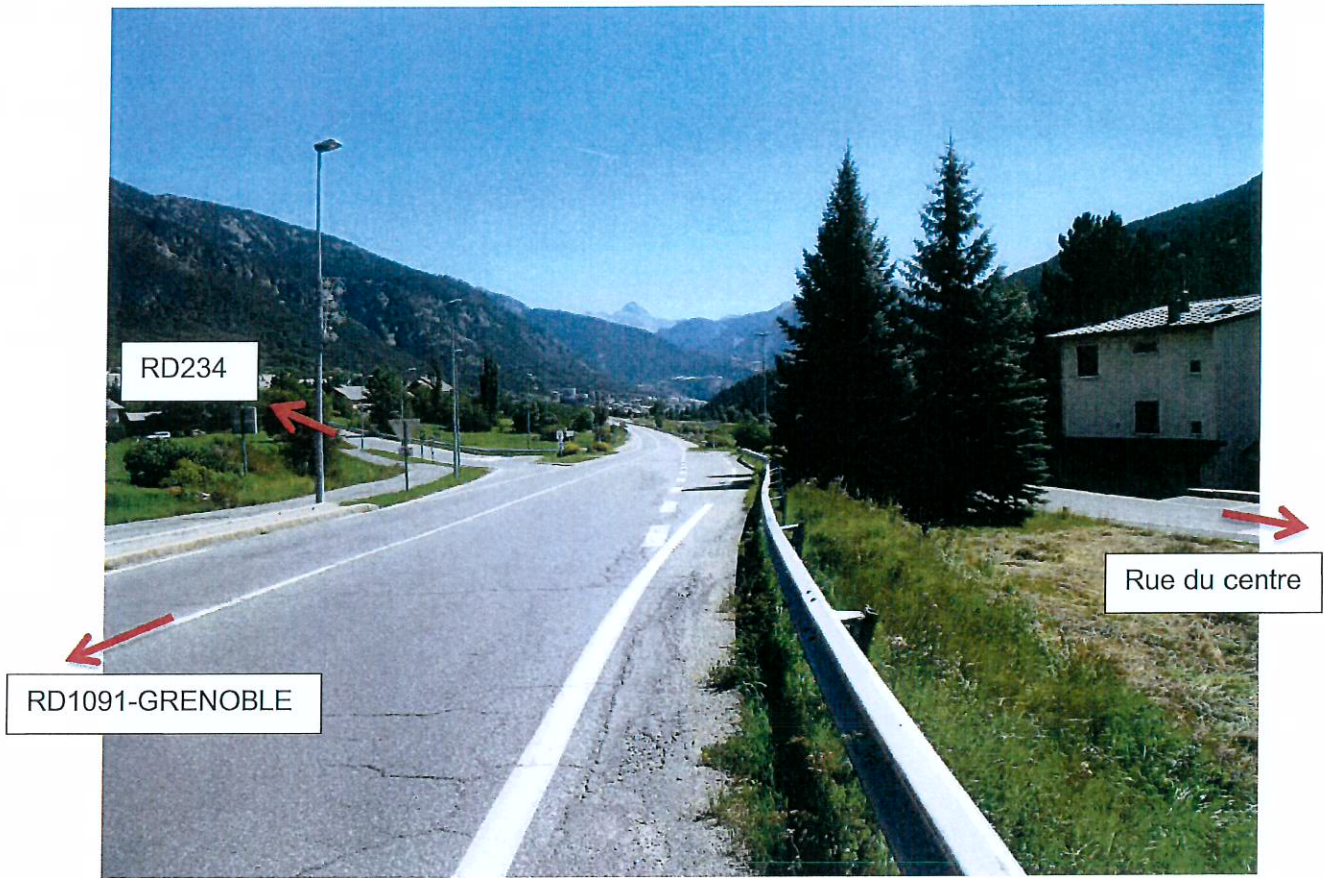
PHOTO 2 Prise de vue dans le sens GRENOBLE-> BRIANÇON
