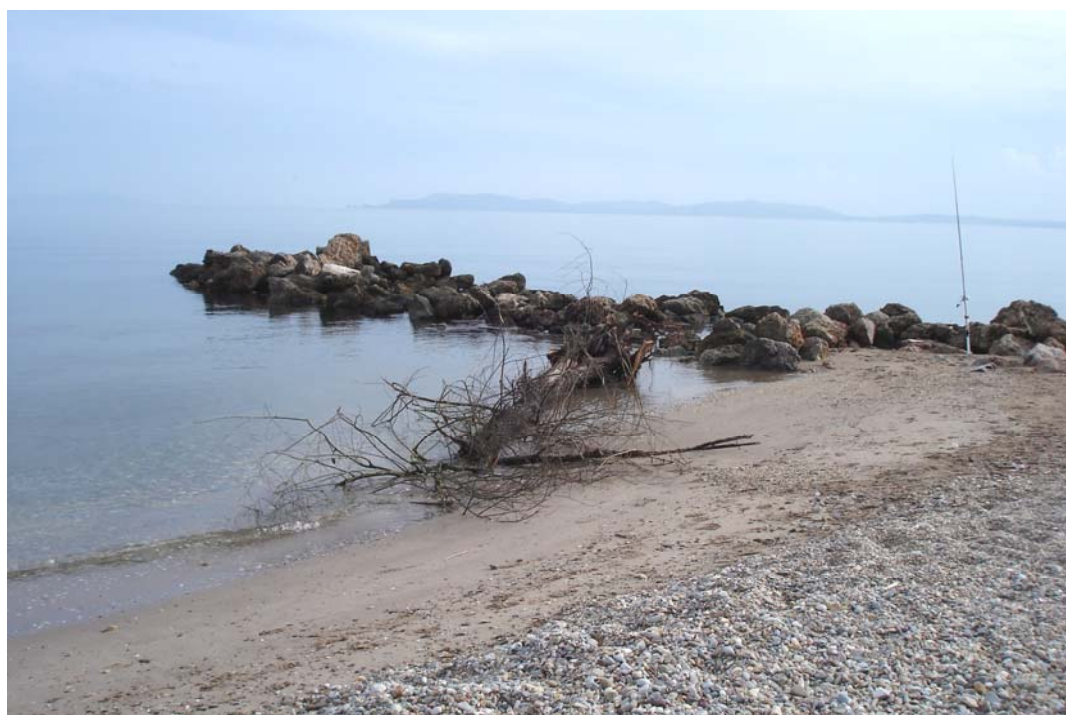
Figure 5 : Enrochement en épave situé à 360 mètres au sud de la zone de rechargement prévue, créant une zone d'accumulation de sédiment. Photo J. Gratiot, le 12/11/08.
