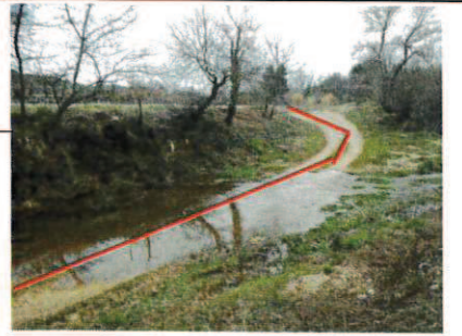
Passage à gué de l'Eze sous chemin
