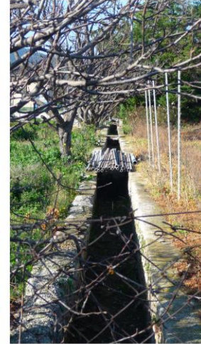
Le canal d'irrigation, vestige du passé horticole du secteur
