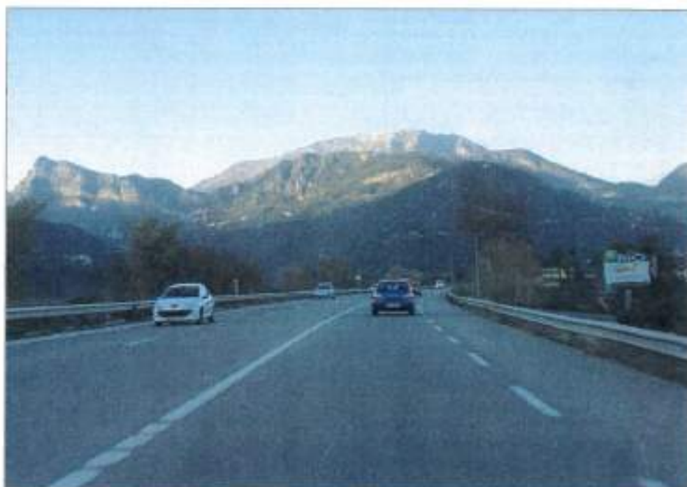
La RM6202 en approche de l'accès à Saint Martin
