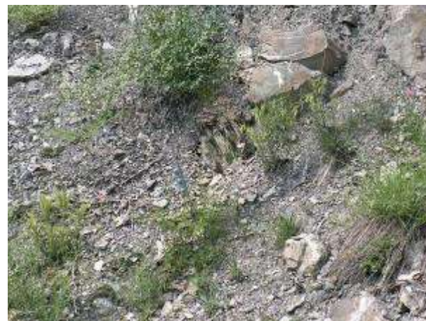
Vue en détail des éboulis (RPa19) en bordure de route (25/06/15)
