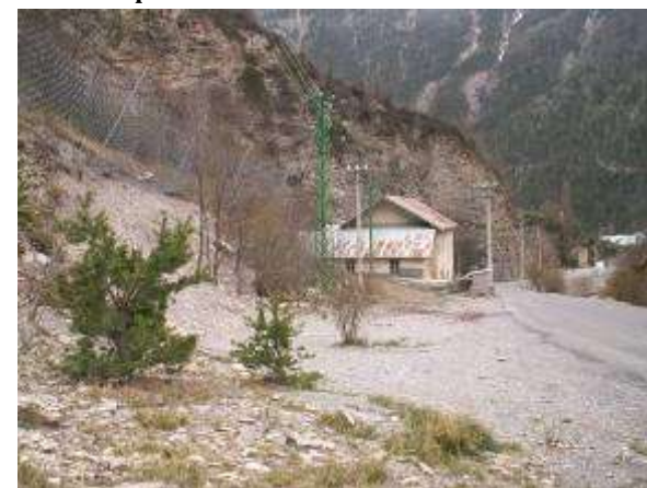
Vue depuis le pont D29 du bâtiment de la centrale
