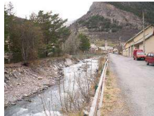
Vue du Parpaillon en aval de la D900 vers sa confluence
