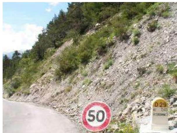
Vue du talus amont de la route au niveau de Remende (25/06/14)
