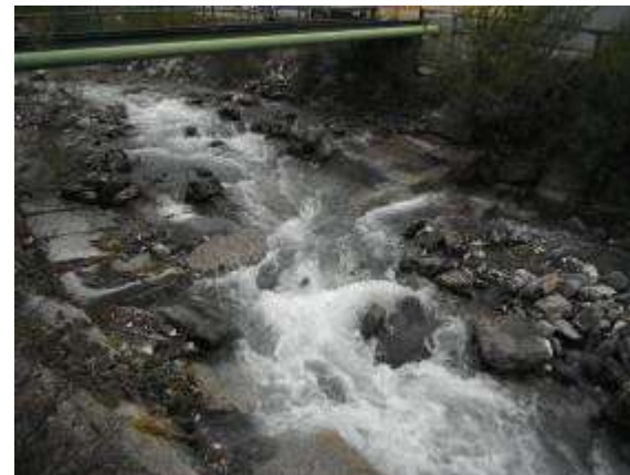
Petit seuil béton en aval proche de la passerelle de la caserne des pompiers (photo du 29/09/2015)
