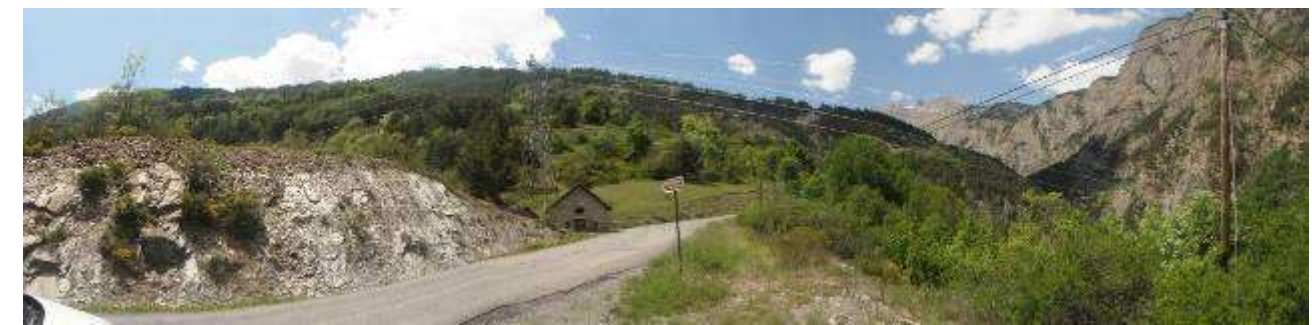
Vue vers l'amont de la gorge du Parpaillon à l'aval de la chapelle Saint-Roch
