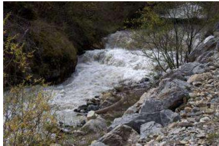
Seuil en aval immédiat de la D29 (ROE50288).
