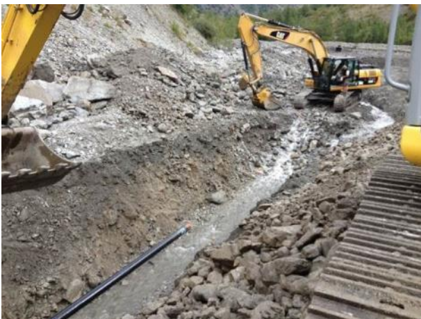
Photo 12_Exemple de tranchée en nappe à 4 m de profondeur (Drac Blanc)
