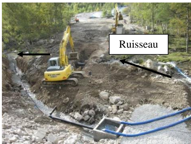
Photo 11_Exemple de passage en sous-œuvre de ruisseau (Réalisation du captage de Vérachous)
