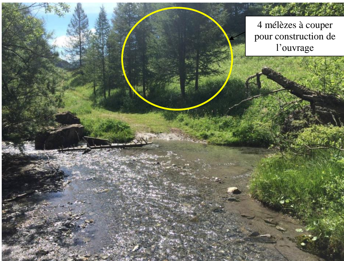
Photo 6_Défrichage à l'emplacement du futur ouvrage (04/07/2017)
