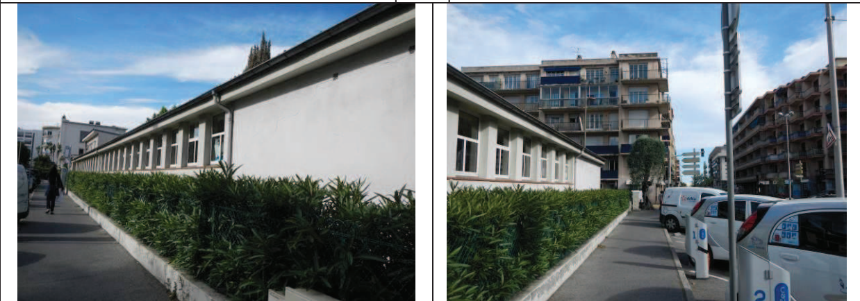
7 Ecole le long de l'avenue Général de Gaulle
