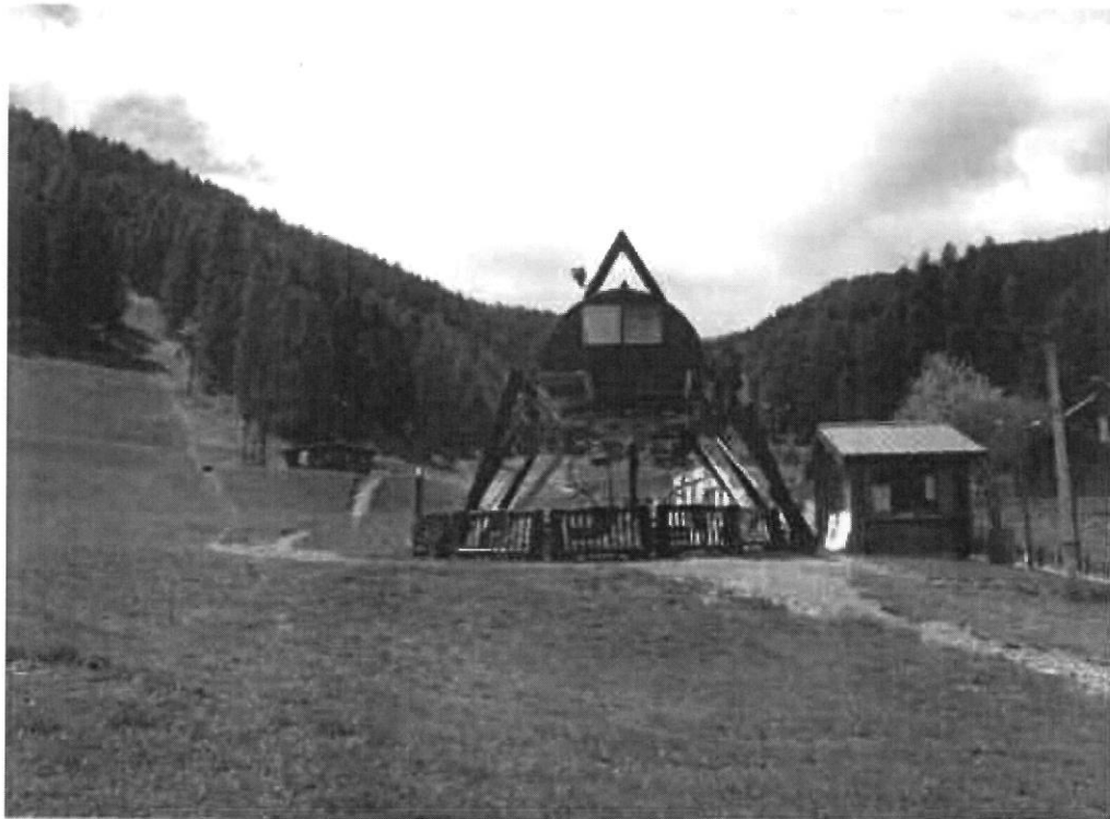
Photographie 1 (printemps 2016) : Gare départ du télésiège des Buisses et gare départ et ligne du téléski de Crébasse à supprimer
