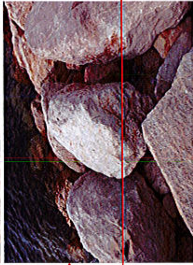
Coude Ouest : enrochements écartés
