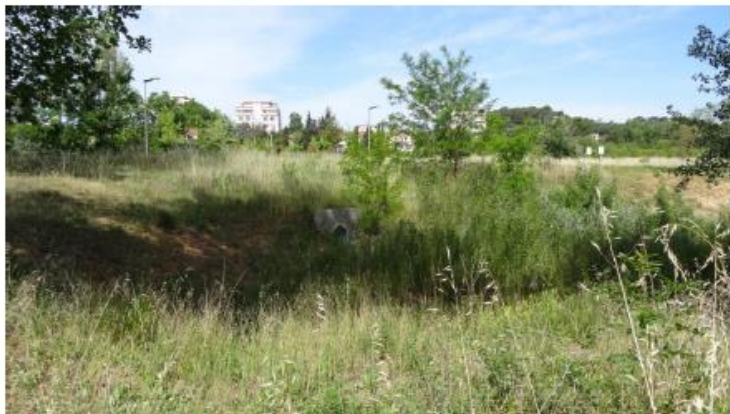
Bassin de rétention existant Source : TPF Ingénierie
