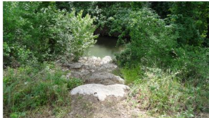
Exutoire du bassin de rétention existant dans l'Arc Source : TPF Ingénierie
