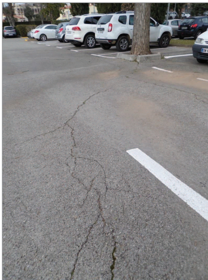
Enrobé soulevé par le système racinaire d'un arbre
