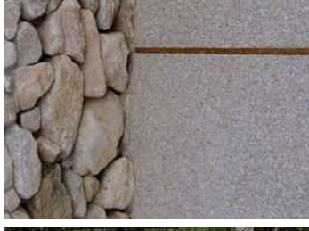
Cheminements piétons en béton désactif
