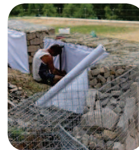
Mise en oeuvre des gabions : drainant et autoportant
