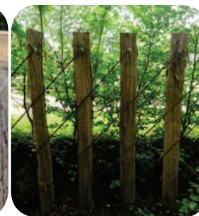
Traitement de limites : piquets de robiniers (Classe.IV)
