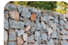
Mise en oeuvre des gabions : drainant et autoportant
