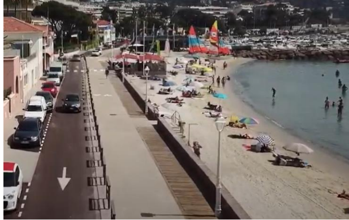
Figure 1 : Boulevard Eugène Gazagnaire au sud du port du Mouré rouge - 2019
