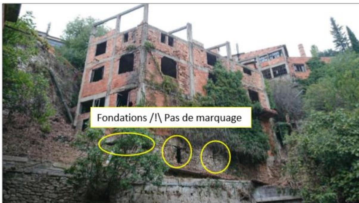
Figure 6 : Ouvertures non marquées à la bombe (sous-sol lumineux et ouvert à tous les vent), à fermer par précaution - P.GIRAUDET
