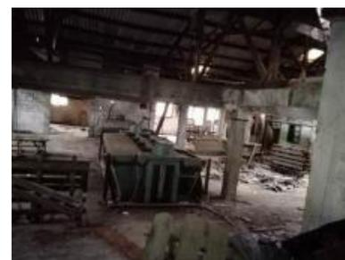
Figure 19 : Etat de délabrement de la charpente – extrait du permis de démolir (ARTELIA, 2020)
