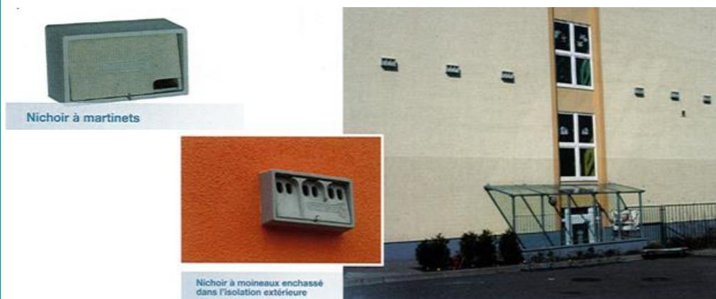
Figure 95 : Exemples de nichoirs à oiseaux directement inclus dans l'isolation extérieure de bâtiments – Source : LPO/ CAUE Isère, 2012
