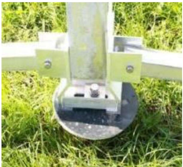
Platine d'une vis d'ancrage (Source : VOLTALIA)
