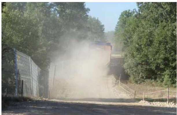
Exemple de levée de poussières lors du passage d'un camion : à éviter
