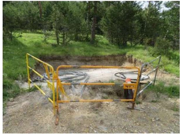
19 : travaux en cours au sein d'une pelouse à Brome érigé
