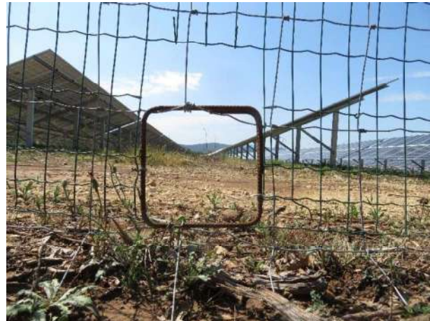
La mise en place de cadres en fer au niveau de ces trouées est important pour renforcer le dispositif sur un temps long.
