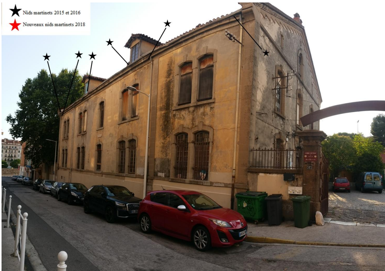
Bâtiment 12 sur lequel des nids artificiels pourront être installés. Des nids sont déjà présents dans les fissures (étoiles), cela renforcera l'attractivité des nids artificiels
