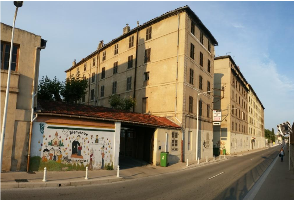
Bâtiment 9-10 sur lequel des nids artificiels pourront être installés. Des nids sont déjà présents sur ce bâtiment.
