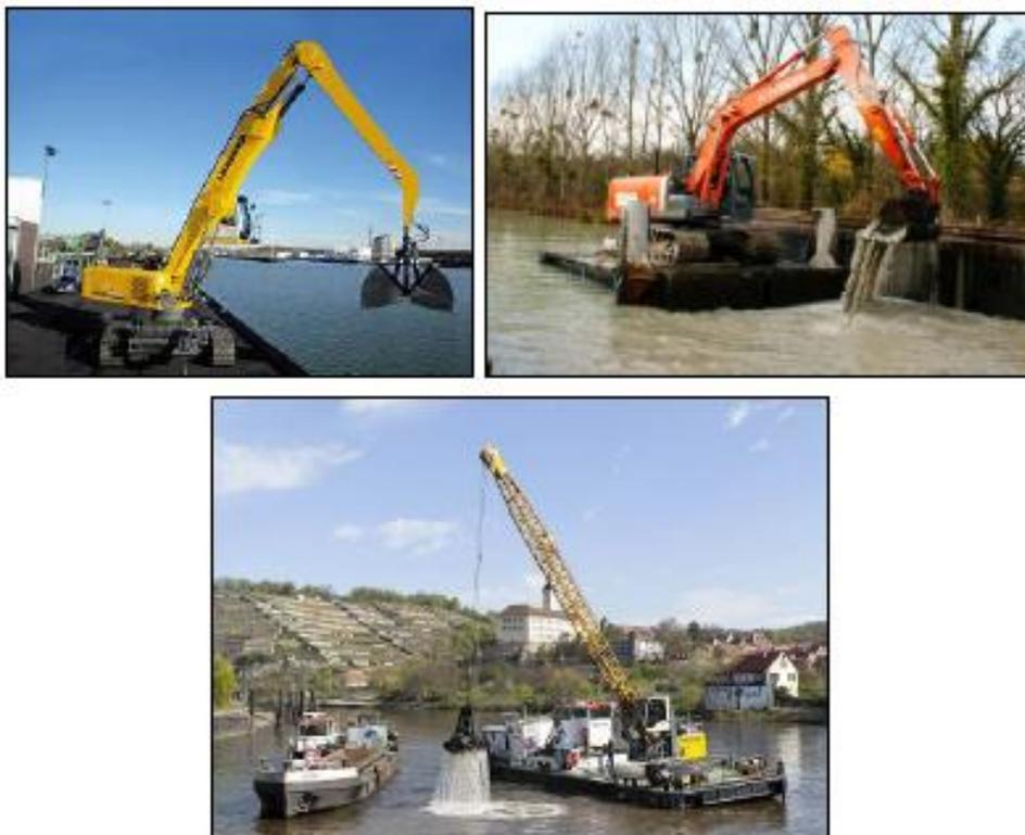
Différents modes d'enlèvement pouvant être utilisés dans le cadre des travaux (en haut : benne preneuse depuis le quai, pelle mécanique sur ponton flottant ; en bas : grue munie d'une benne preneuse sur ponton flottant et un chaland fendable).
