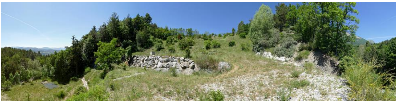
Le confortement de l'ancien ISDND au sud du site
