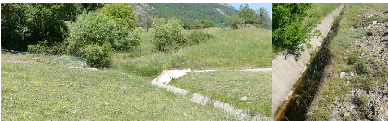
Le cours d'eau - A gauche, le débouché du cours d'eau naturel vers l'ancien ISDND. A droite, la section canalisée.
