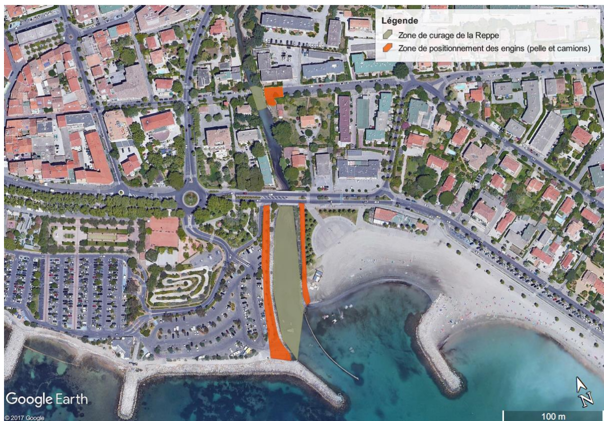
Figure 1 : Localisation des zones de travaux pour le curage de la Reppe
