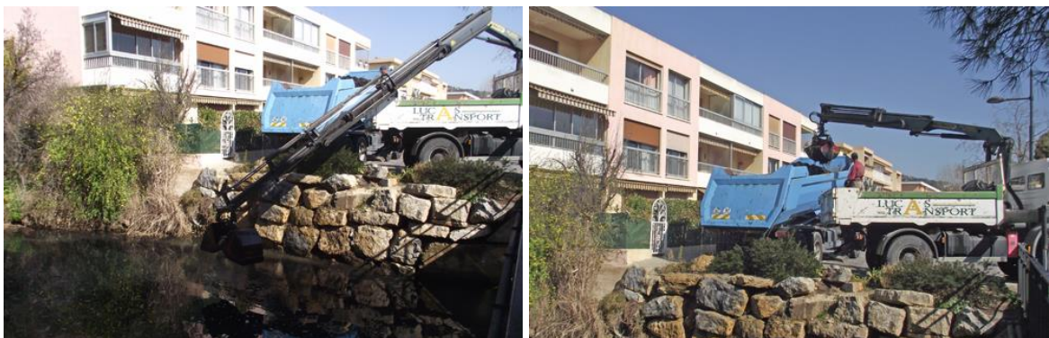
Figure 4 : Curage de la Reppe en mars 2012 (ouest-var.net)
