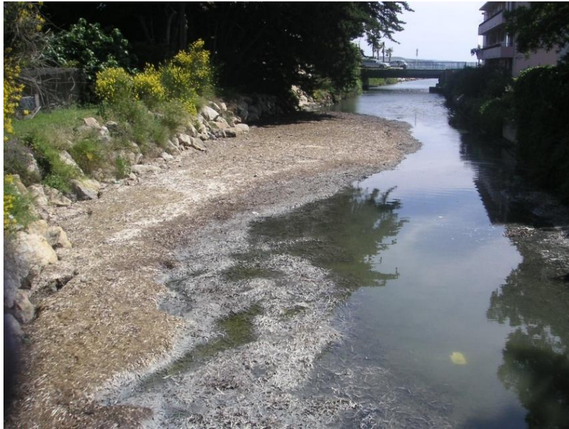
Figure 2 : Dépôts entre le pont routier de la Promenade Charles de Gaulle et le pont piéton du Boulevard des Ecoles
