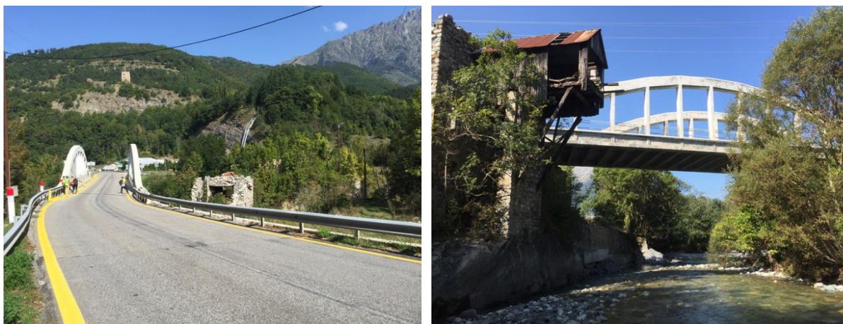
Pont des Richards (source : Ingérop)
