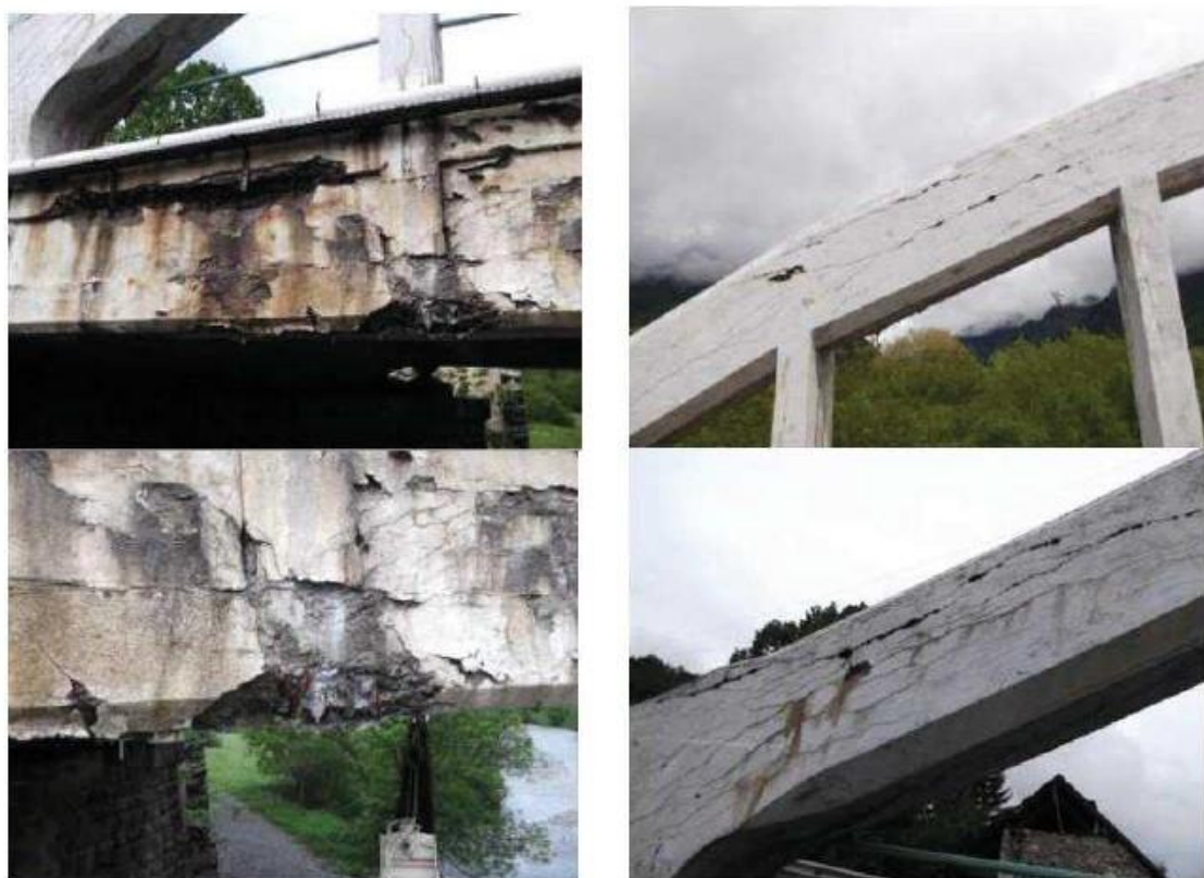
Exemple de dégradations (source : CEREMA)
