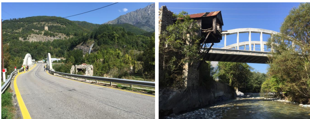
Pont des Richards (source : Ingérop)
