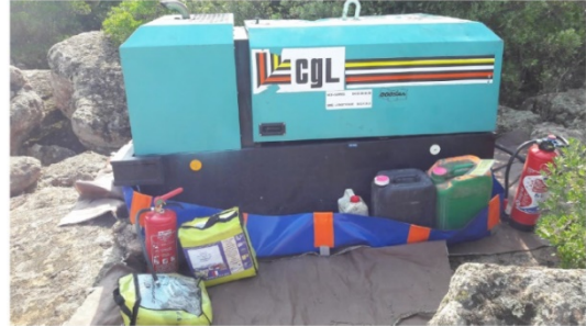
Exemple du stockage d'un compresseur et de petit matériel au-dessus d'une falaise avec bac de rétention et tapis absorbant
