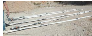
Barres d'ancrage équipées de géotextile (Photo : Naturalia)
